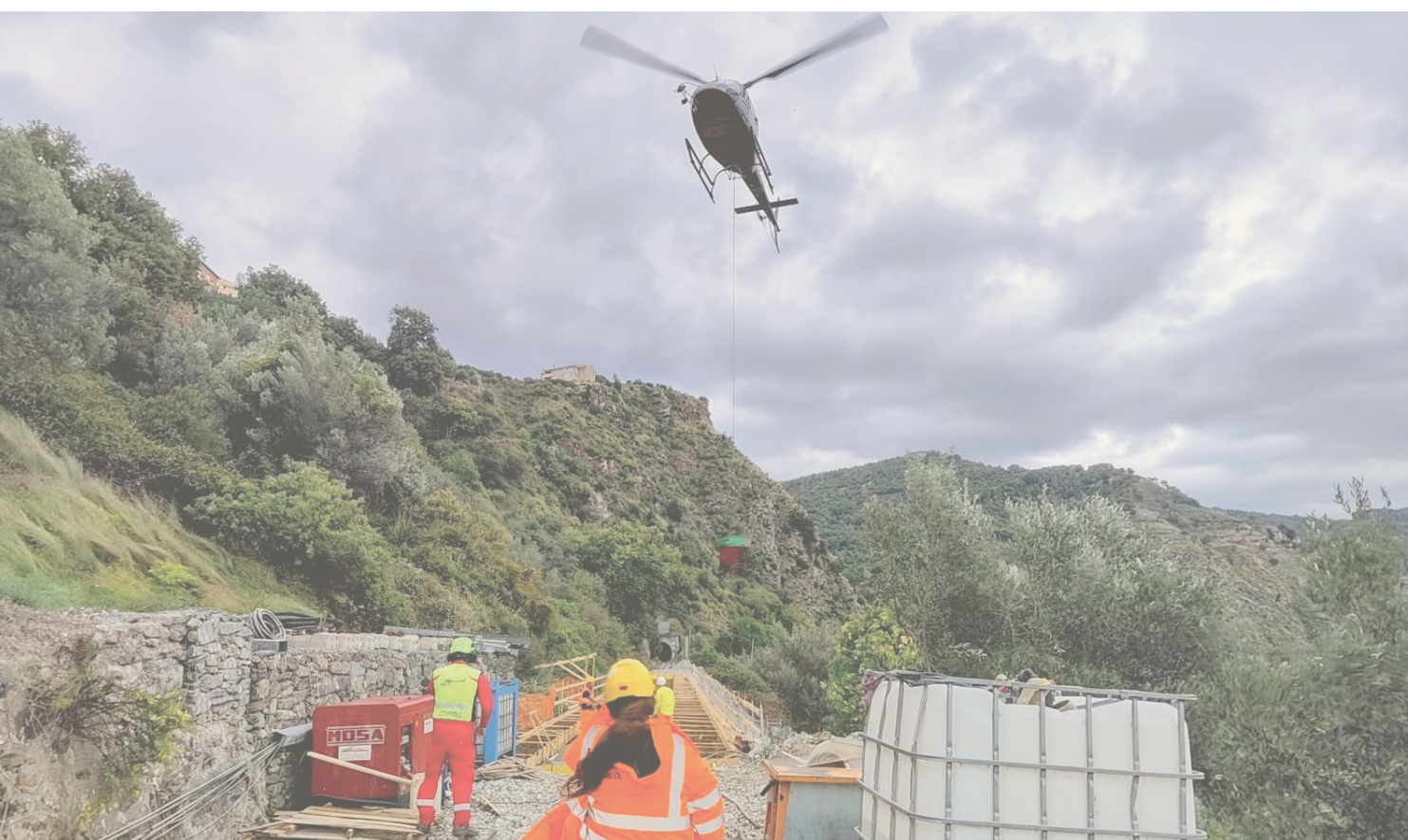
Messa in sicurezza di viadotti, ponti e ponticelli ricadenti - Linea ferroviaria storica di montagna che collega Cosenza a Catanzaro.
