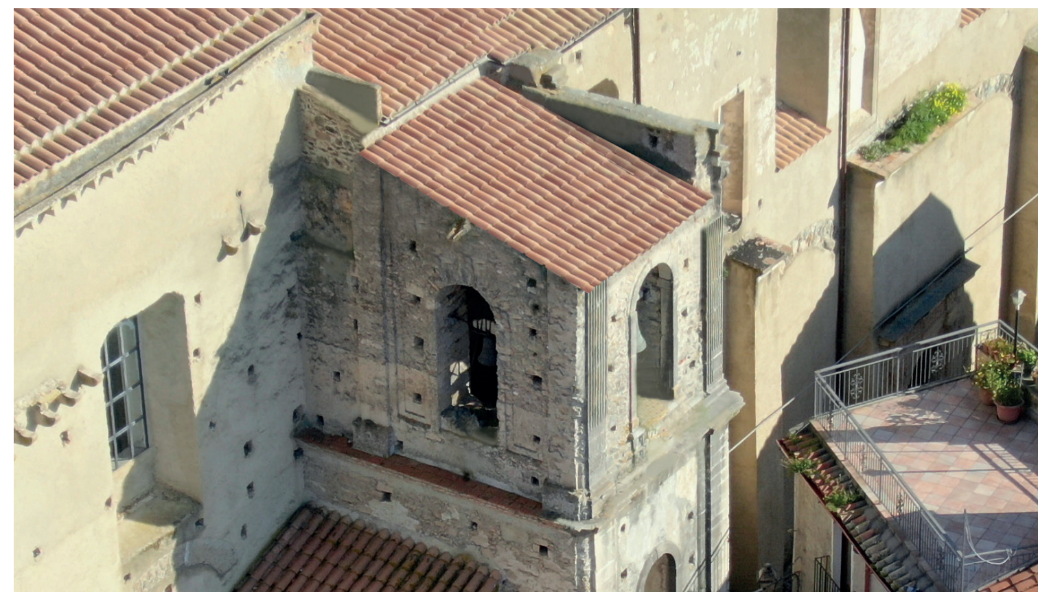
Messa in sicurezza sismica del campanile della Chiesa Matrice - Fiumefreddo Bruzio (CS)
